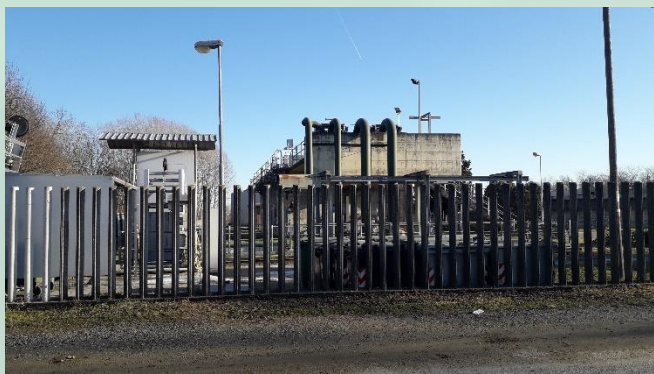
FIGURA 1 DEPURATORE ACQUE REFLUE DI CERETTA
